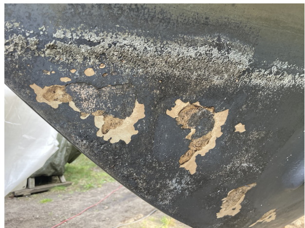
Abbildung 3: Lokalfreigelegtes Laminat am Schiffsrumpf.
